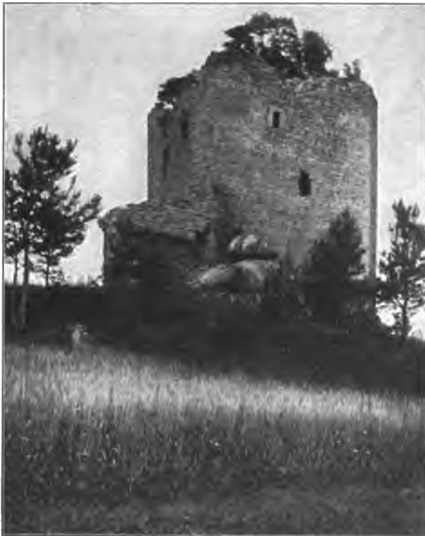
Fig. 54. Lobenstein. Der Burgturm. Ostansicht.
